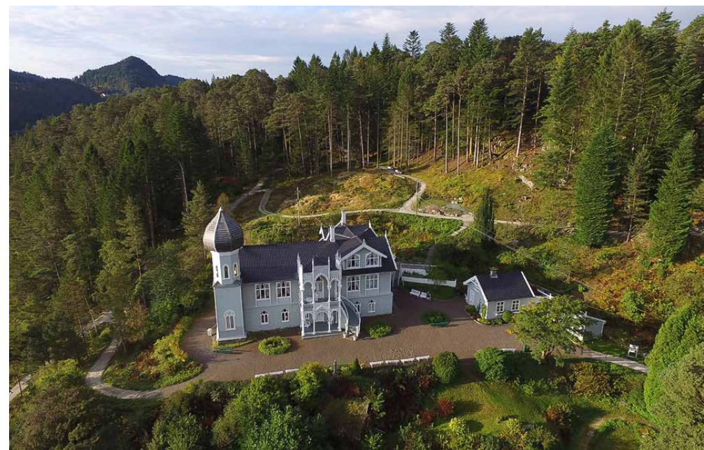
Det er i 2017 blant annet gjennomført flere brannsikringstiltak på Ole Bulls Lysøen.
